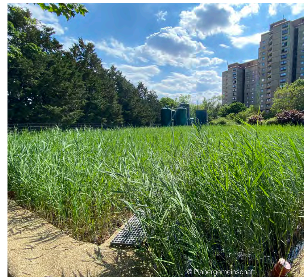
Der bewachsene Bodenfilter der Pflanzenkläranlage
