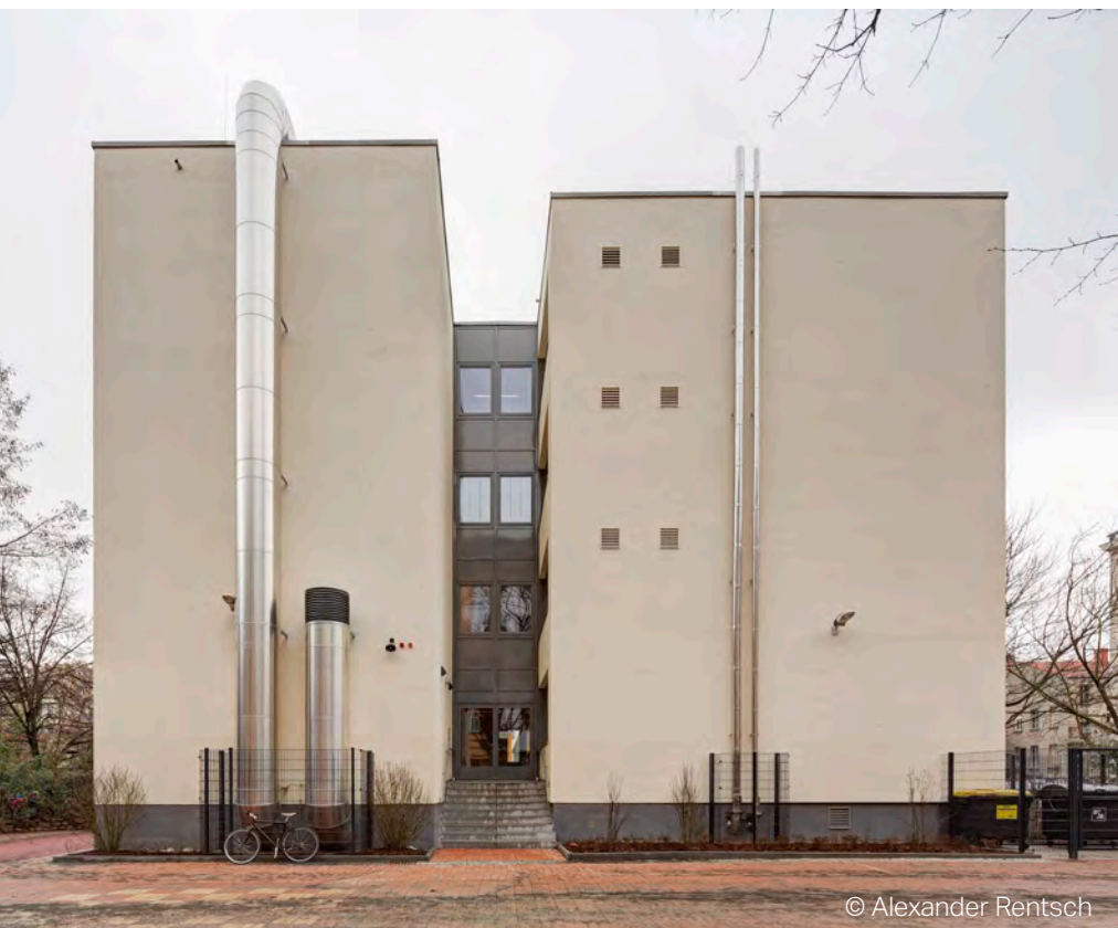
Außenansicht der zentralen Lüftungs- und Heizanlage
