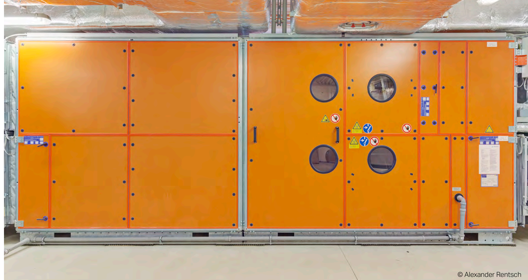
Heizungsanlage (Blockheizkraftwerk)
