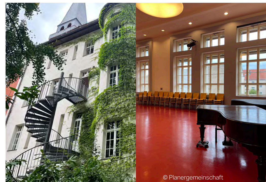
links: Neue äußere Fluchttreppe, rechts: Sanierte Aula
