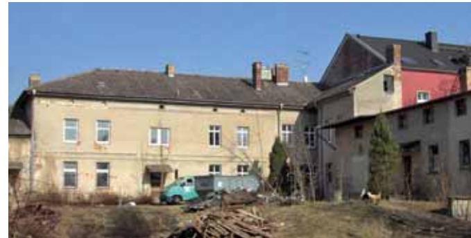
Fotos: Bestand vor dem Umbau
