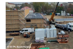
© SE FM, Bezirk Pankow Schulneubau mit Holzmodulen
