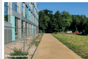
Erschließungsweg zwischen Ehrenmal und Schulneubau
