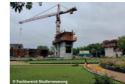
© Fachbereich Stadterneuerung Treppenhäuser in Stahlbetonbauweise
