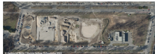
© Geoportall Berlin / Digitale farbige Orthofotos 2022 Baustellenvorbereitung nach der Tiefenerdämmung
